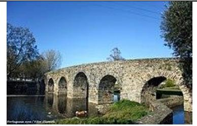
A ponte, com cerca de 64 metros de comprimento, assenta sobre seis arcos redondos de alvenaria de pedra.
